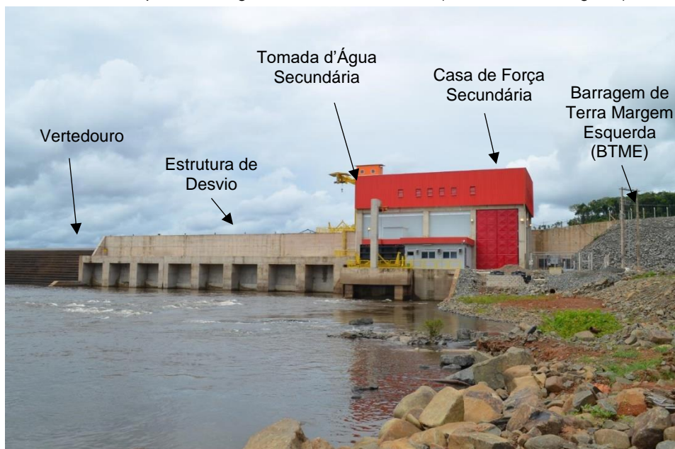
Figura 7. Vista Geral da Central Hidrelétrica Complementar
