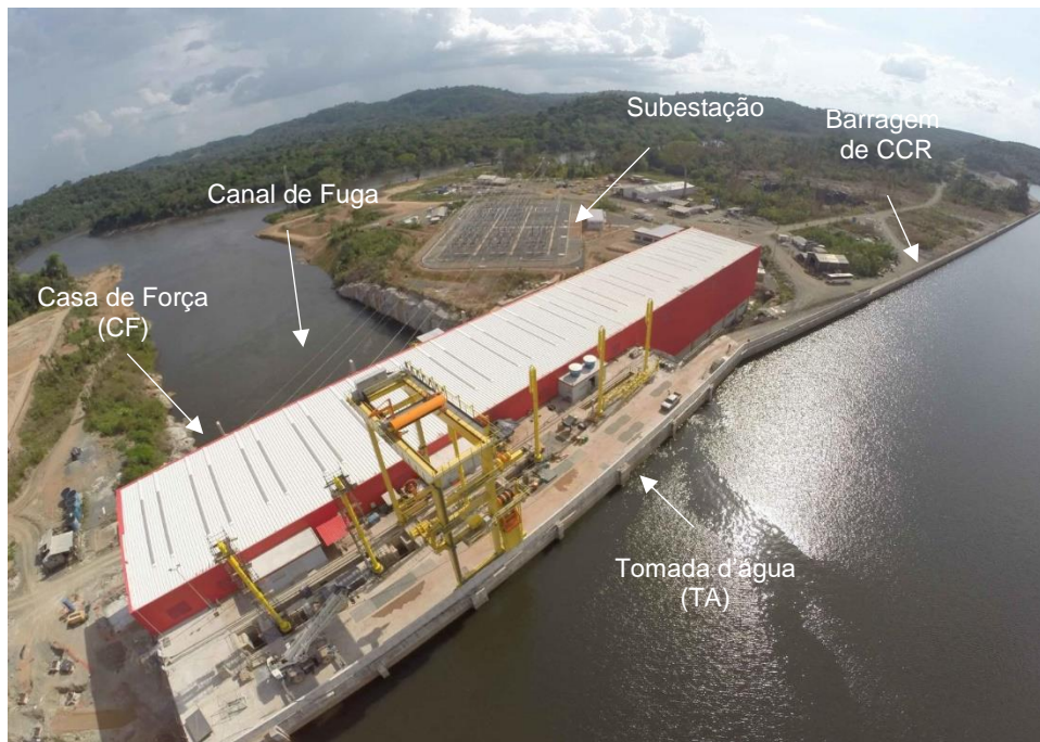
Figura 6. Vista geral da Estrutura Principal.
