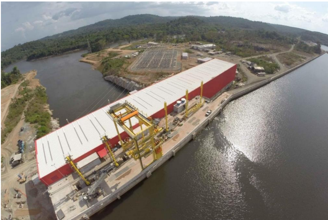
Figura 10. Vista geral da Estrutura Principal.
