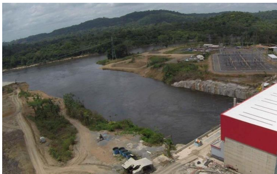
Figura 8. Canal de Fuga.
