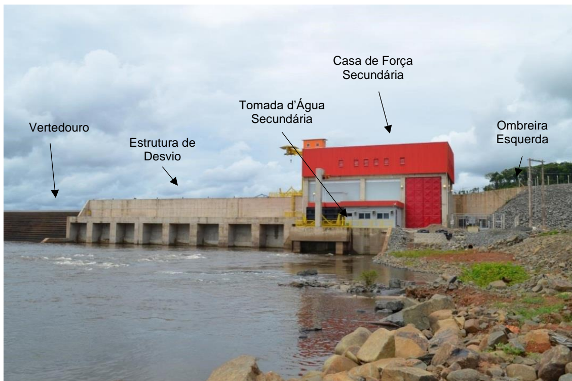
Figura 11. Vista Geral da Central Hidrelétrica Complementar Fonte: Companhia Energética do Jari - CEJA S.A. (05ABR2017 – Imagem7).
